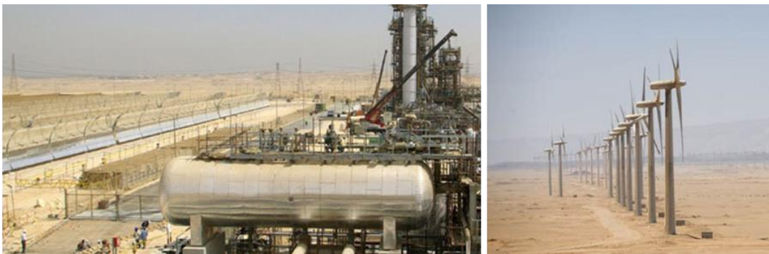
Abbildung 4 Kuraymat - Gas-Dampfturbinen-Kraftwerk mit Parabolspiegelfeld und Zafarana Windpark in Ägypten
