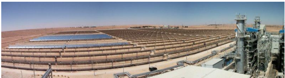
Abbildung 3 Hassi R'Mel Gas-Dampfturbinen-Kraftwerk mit Parabolspiegelfeld in Algerien
